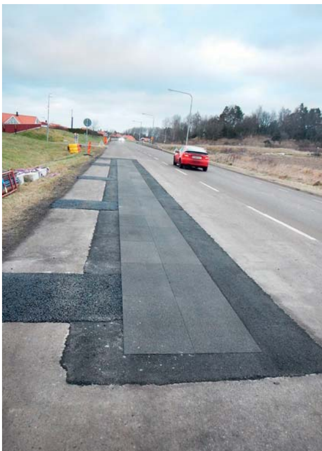
Rys. 1. Odcinek doświadczalny pokryty nawierzchnią poroelastyczną PERS-HET usytuowany na jednej z ulic w mieście Linköping, Szwecja
