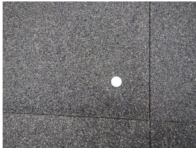
Rys. 2 Nawierzchnia poroelastyczna PERS-HET na odcinku doświadczalnym w Szwecji
