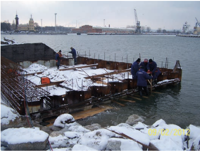
Rys. 13. Wykonywanie oczepu grodzki u nasady falochronu
