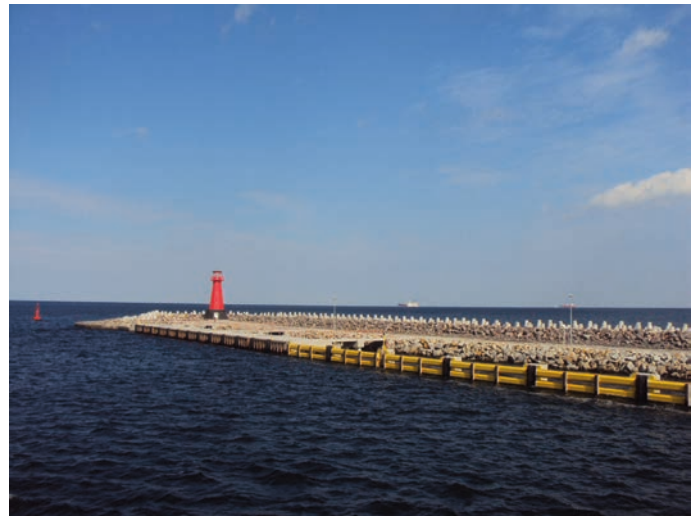
Rys. 15. Falochron po przebudowie
