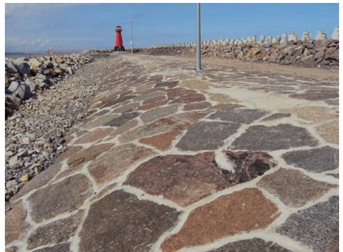
Rys. 17. Widok na wyremontowany dawny korpus
