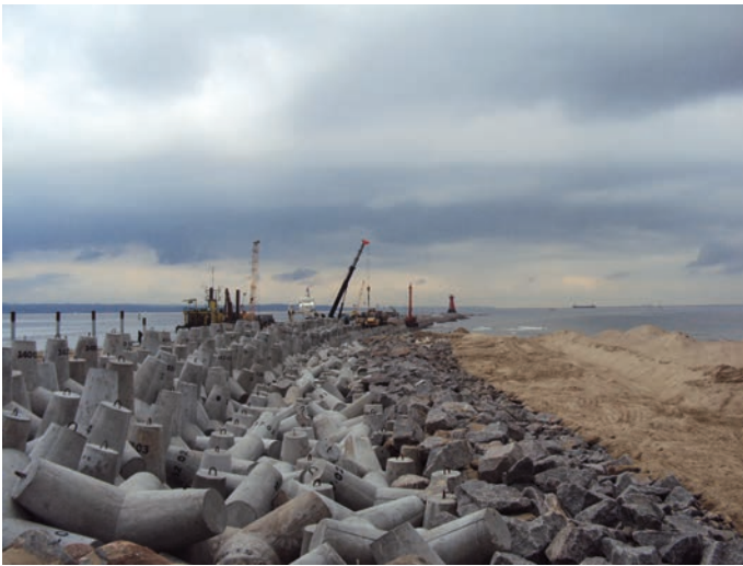
Rys. 12. Kolejne etapy prac
