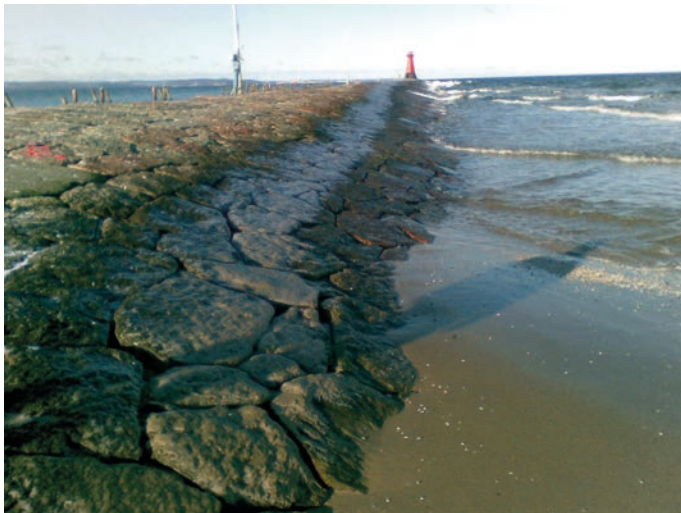
Rys. 3. Kamienna wykładzina falochronu przed przebudową
