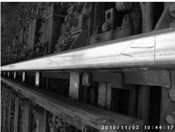
Rys. 14. Wady head check na powierzchni tocznej opornicy
