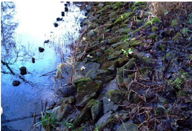
Rys. 7. Umocnienie brzegu narzutem kamiennym – schemat istniejącej konstrukcji
