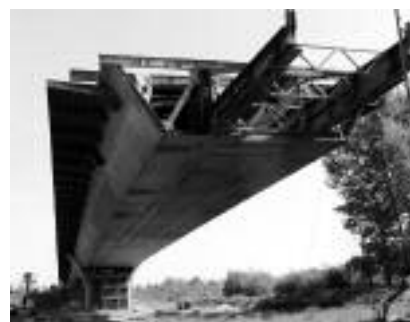
Fot. 2. Montaż przęśla ze wspornikiem max. długości 108 m
