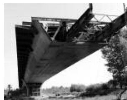
Fot. 2. Montaż przęsła ze wspornikiem max. długości 108 m
