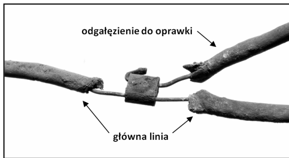
Rys. 12. Sposób łączenia kabli wewnątrz złączki
