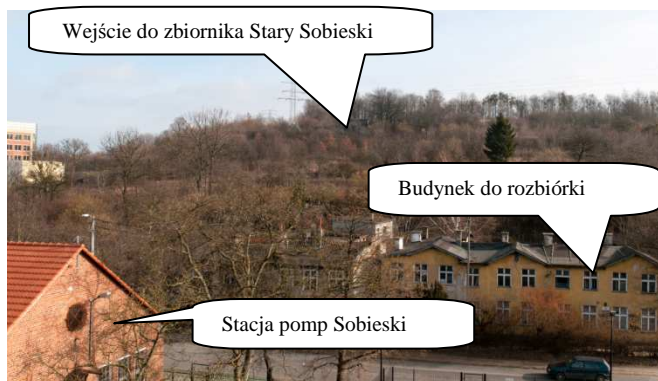
Fot. 1. Widok wzgórza Szubienicznego i stacji pomp Sobieski z budynku LINTE 2 przy ul. Sobieskiego 5
