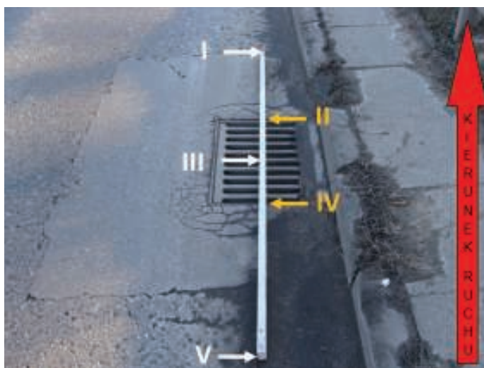
8. Sposób pomiaru deformacji wpustu ulicznego
