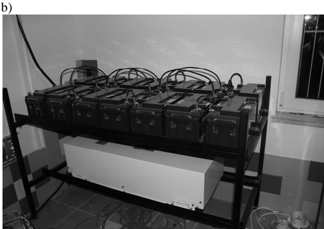
Rys. 3. Widok elektrowni wiatrowej a) i magazynów energii b)
