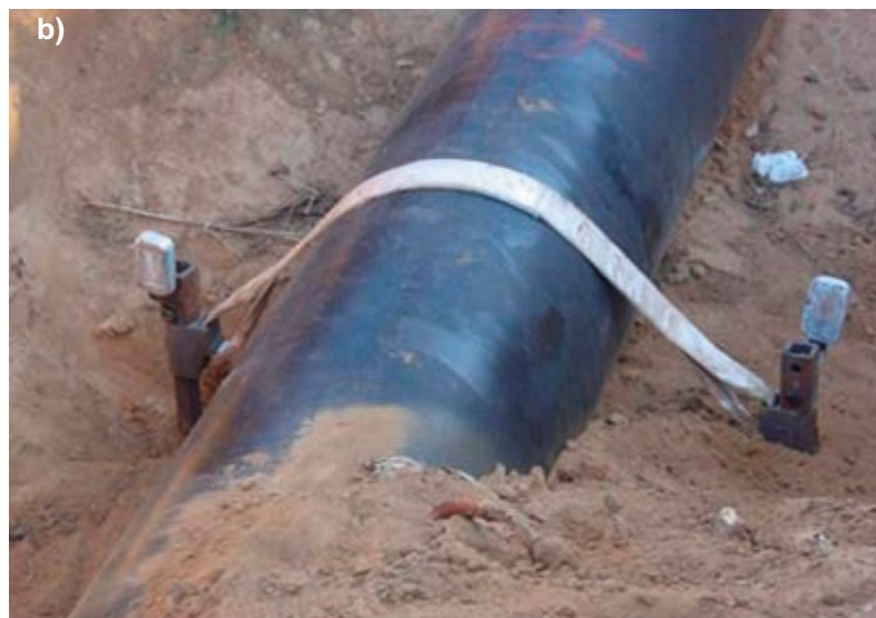
Rys. 5. Etapy montażu zakotwienia rurociągu ułożonego w wykopie za pomocą stalowych wkręcanych kotew gruntowych a) wkręcanie pojedynczej kotwy, b) widok zamontowanej nakładki kotwiącej przed zasypaniem wykopu gruntem [11]
