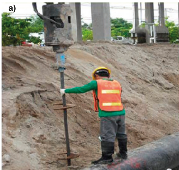
Rys. 5. Etapy montażu zakotwienia rurociągu ułożonego w wykopie za pomocą stalowych wkręcanych kotew gruntowych a) wkręcanie pojedynczej kotwy, b) widok zamontowanej nakładki kotwiącej przed zasypaniem wykopu gruntem [11]
