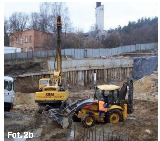
Fot. 1. Palisada przy realizacji budynku mieszkalnego w Gdyni (wyk. i fot. Fundament Specjal)
