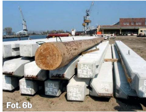
Fot. 6. Prefabrykаты żelbetowej ścianki szczelnej nabrzeża w Porcie Gdańskim (fot. K. Gwizdała)
