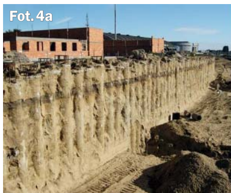
Palisada ażurowa z pali CFA Odcinek 1: średnica pali – 430 mm, długość – 4,5 do 7,5 m, rozstaw osiowy – 0,6 m Odcinek 2: średnica pali – 630 mm, długość – 8,5 do 11 m, rozstaw osiowy – 0,8 m Odcinek 3: średnica pali – 800 mm, długość – 12 do 13 m, rozstaw osiowy – 0,9 i 1 m Głębokość wykopu: od 3 do ok. 5,7 m
