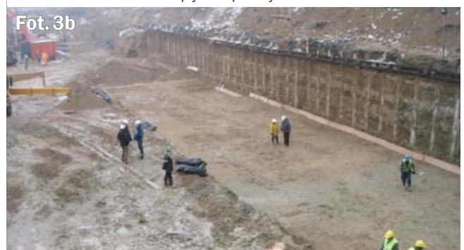
Fot. 3. Palisada przy realizacji budynków „Quatro Towers” w Gdańsku (fot. K. Gwidziało)
