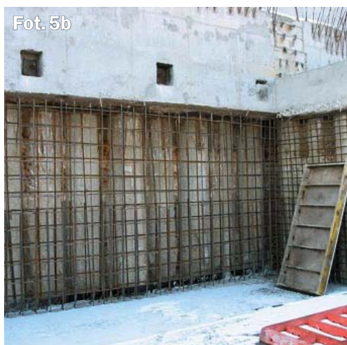
Palisada z pali CFA Średnica pali: 500 mm Długość pali: 9,5–12 m Głębokość wykopu: ok. 6,5 m Schemat statyczny: jednokrotnie zakotwiona
