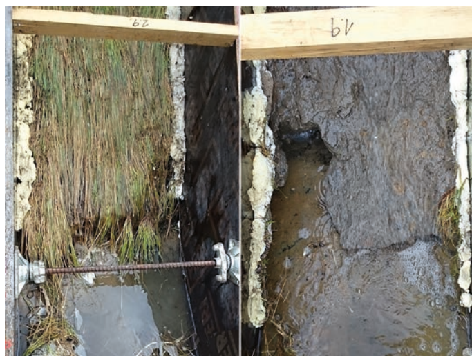
Rys. 17. Stopa wału na warstwie gliny – powierzchnia poślizgu pomiędzy gliną i mieszaniną piasku i popiołu. Sekcja 9 kanału 1 (po prawej) i kanału 2 (po lewej) po piątym etapie badań (porośnięta)
