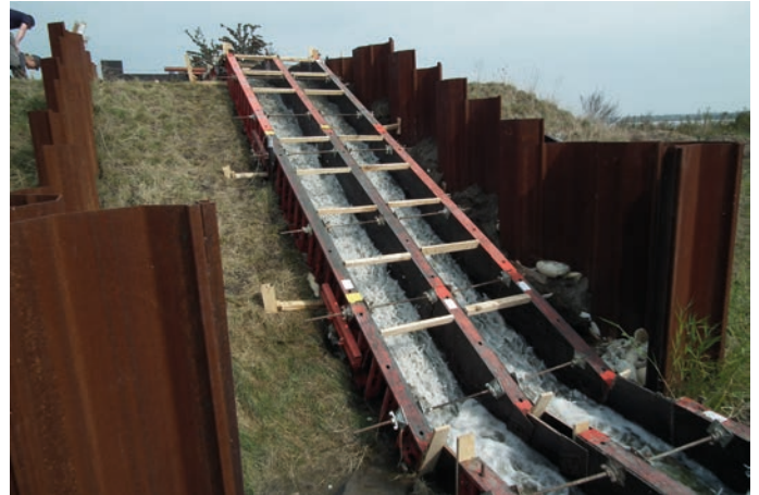
Rys. 5. Wał badawczy z widocznymi kanałami – przygotowanie do eksperymentów przelewowych
