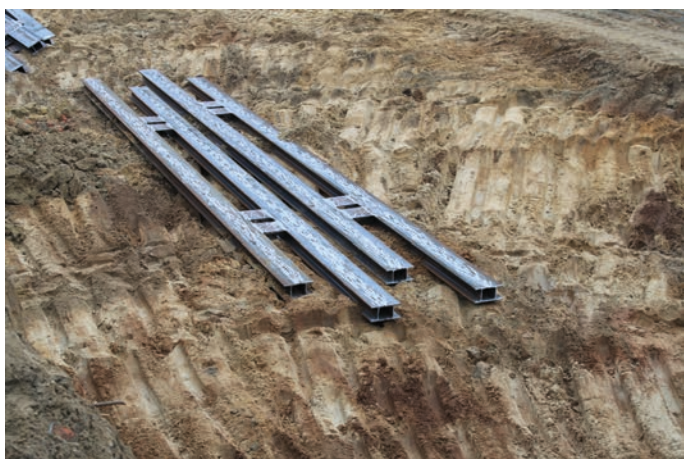
Rys. 5. Budowa Nowego Centrum Sopotu. Kleszcze górnego poziomu
