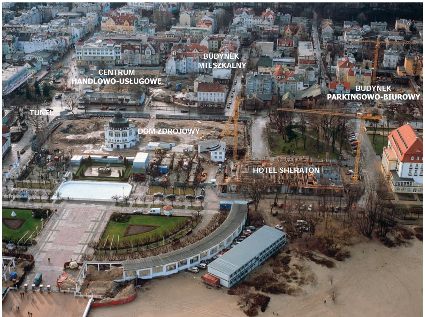
Rys. 11. Widok na Centrum Haffnera w trakcie realizacji (fot. NDI S.A.)
