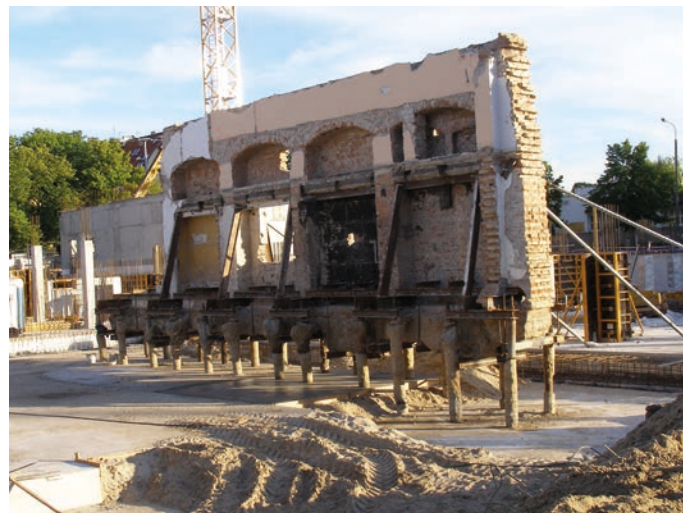
Rys. 15. Podchwycona ściana Rotundy – element pozostawiony do włączenia w nową konstrukcję Domu Zdrojowego [22]
