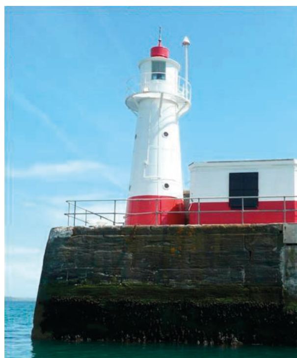
Rys. 7. Stacja mareograficzna obok latarni morskiej w Newlyn [31]
