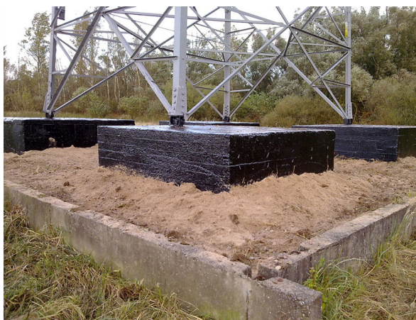
Rys. 3. Przykład fundamentu słupa energetycznego wysokiego napięcia 110 kV
