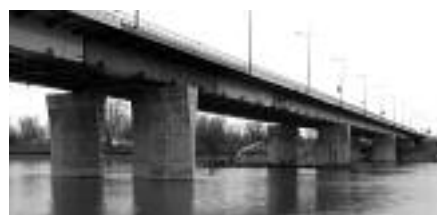
Fot. 2. Odbudowany most Łazienkowski
