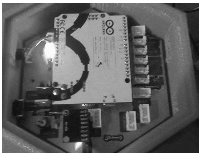
Rys. 4. Płytką drukowaną po montażu
