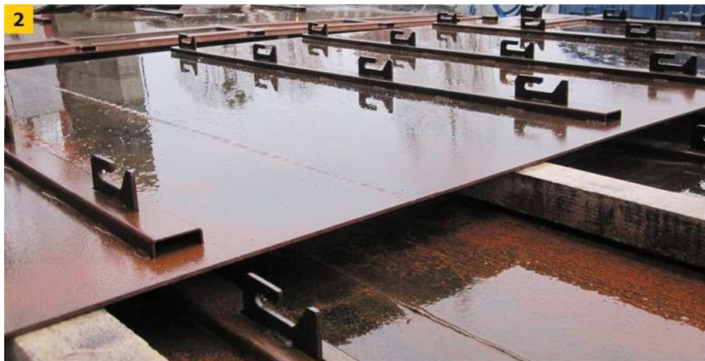
FOT. 2. Przykład zastosowania okładziny ze stali typu corten o podwyższonej odporności na warunki atmosferyczne na budynku ECS w Gdańsku: składowana blacha elewacyjna z widocznymi zawieszami (2); fot.: archiwum autora
