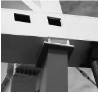
Fot. 2. Połączenie dźwigara dachowego ze słupem
