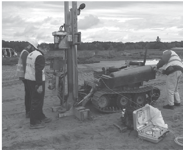
Rys. 2. Badania dylatometryczne na platformie roboczej
