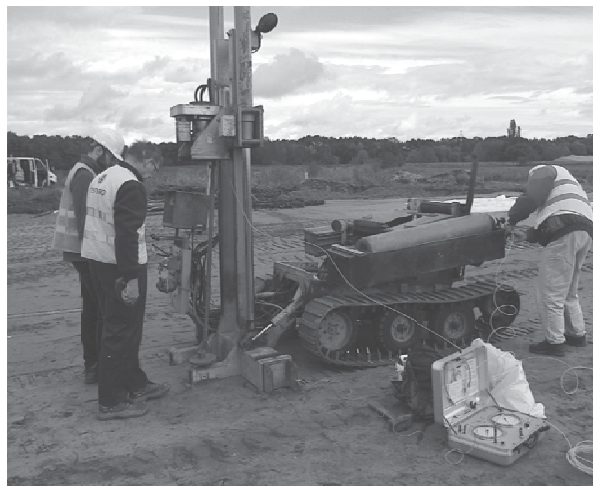
Rys. 2. Badania dylatometryczne na platformie roboczej
