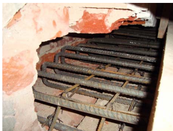
Ryc. 9. Żelbetowa klatka schodowa: a) zbrojenie schodów, b) oparcie zbrojenia na ścianie zabytkowej
