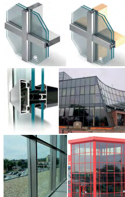
Rys. 4. Przykłady rozwiązań konstrukcyjnych ścian słupowo-ryglowych
