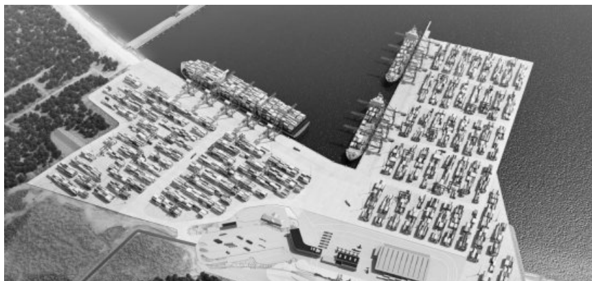
Rys. 4. Drugi terminal DCT w Gdańsku, N.V.BESIX [15]
