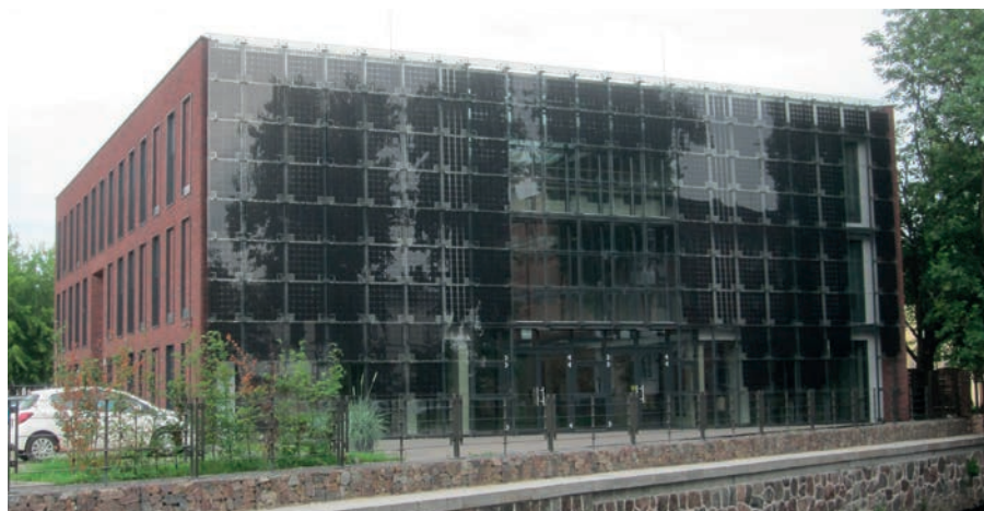
Fot. 5. Szklana fasada z ogniwami fotowoltaicznymi
