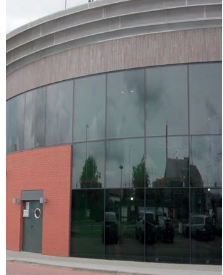
Fot. 4. Szklana fasada wykonana ze szkła giętego
