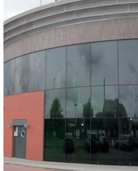
Fot. 4. Szklana fasada wykonana ze szkła giętego
