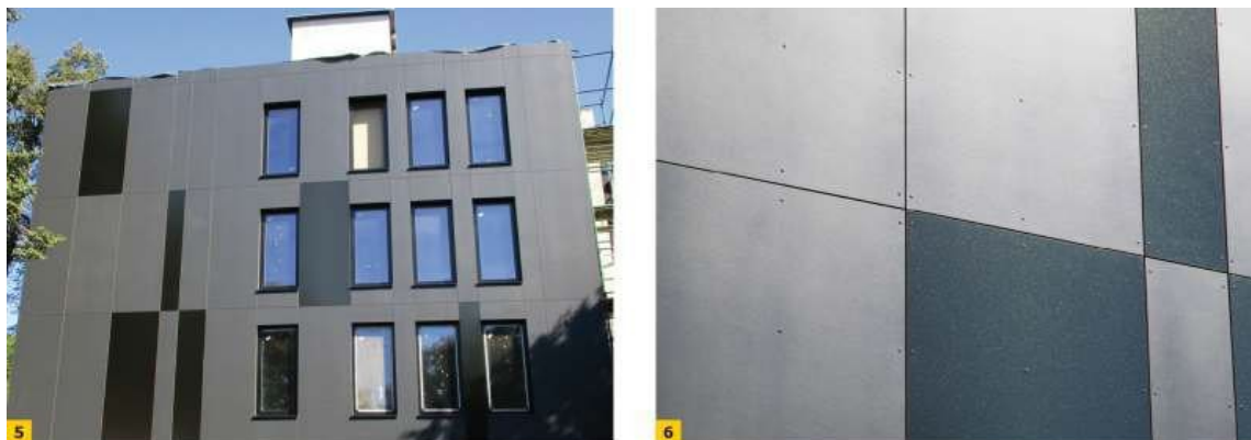
FOT. 5-6. Przykład elewacji z okładziną montowaną na nity do podkonstrukcji aluminiowej; fot. archiwum autora
