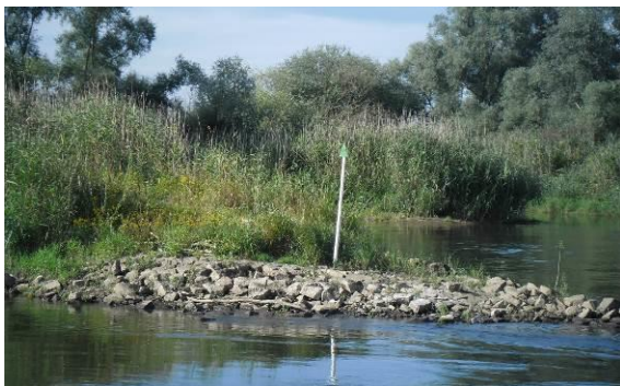
Rys.2 Budowla regulacyjna na Odrze [fot. Sobkowicz P.]
