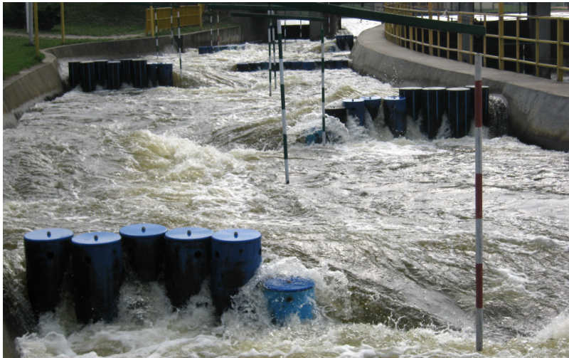
Ryc. 2. Widok na tor kajakarstwa górskiego w Drzewicy Fig. 2. View of the canoeing white water course in Drzewica (Poland)
