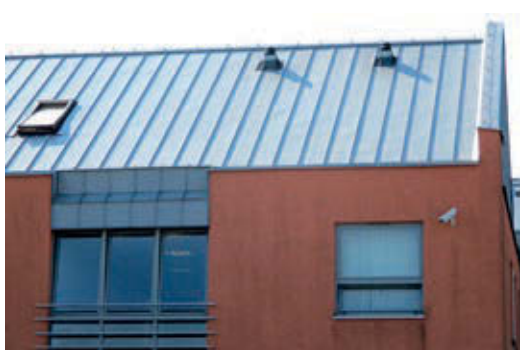
Rys. 8. Blachy stalowe w budownictwie mieszkaniowym
