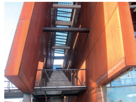
Rys. 5. Fasada obiektu użyteczności publicznej ze stali odpornej na korozję atmosferyczną – ECS Gdańsk
