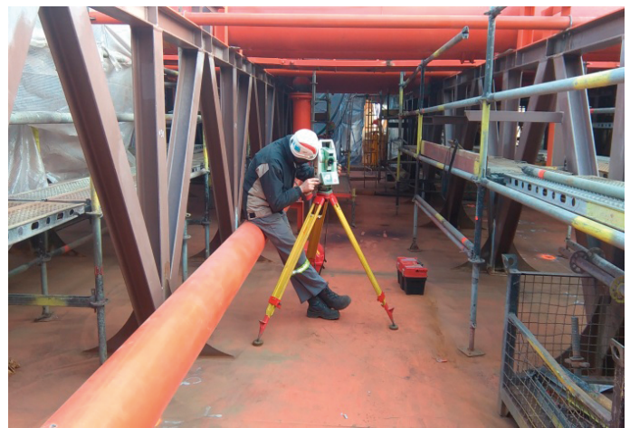
Rys. 6. Prace przygotowawcze do pomiarów geodezyjnych na pokładzie budowanej konstrukcji (fot. Firma U-H DIAZ)
