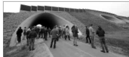
Wycieczka techniczna na budowę drogi S5 – Poznań – Wrocław. Obiekty inżynierskie w technologii konstrukcji podatnych z blach falistych [Fot. archiwum ViaCon Polska]
