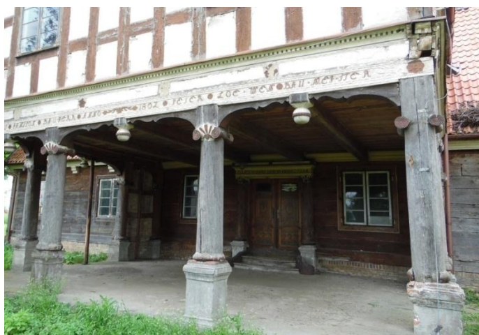
Fot. nr 10 Dom podcieniowy w Orłowie. (fot. Autor)
