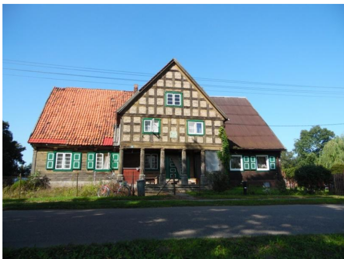
Fot. nr 3 Dom podcieniowy w Gniazdowie, typ III. (fot. Autor)
