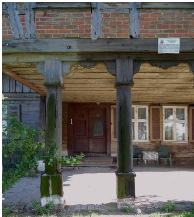
Fot. nr 6 Dom podcieniowy w Lasowicach Wielkich. (fot. Autor)
