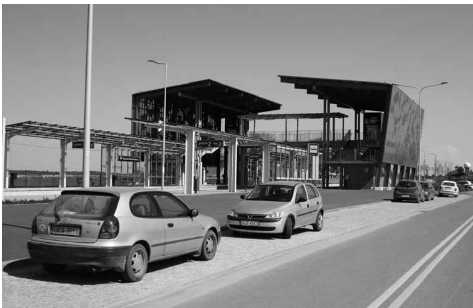
Przystanek Gdańsk Rębiechowo zintegrowany z parkingiem strategicznym Park & Ride (w budowie), mającym obsługiwać miejscowości podmiejskie (fot. D. Załuski)
