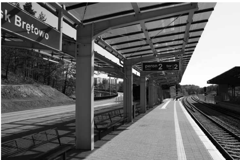
Pierwszy w Polsce przystanek Gdańsk Brętowo łączący na jednym peronie linię kolejową z linią tramwajową (fot. D. Załuski)
