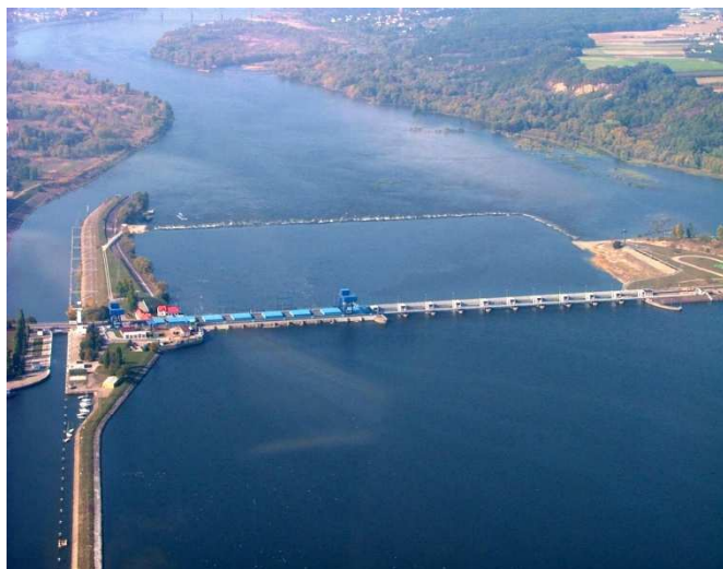
Rys. 3. Stopień Włocławek – widok od wody górnej [19]
