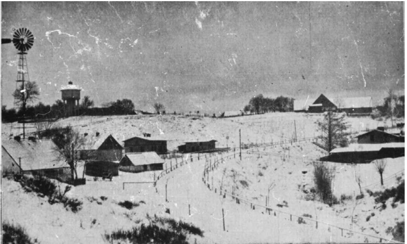
Rys. 2. Widok urządzeń wodociągowych na Oksywiu
