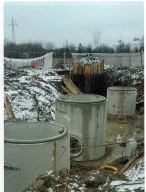
Fot. 1. Teren budowy – komory pomiarowe
