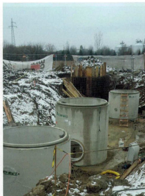
Fot. 1. Teren budowy – komory pomiarowe
