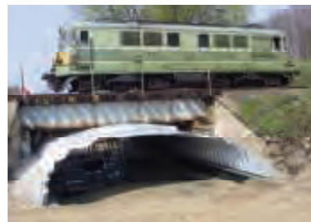
1. Przebudowa obiekt belkowego na gruntowo-powłokowy
