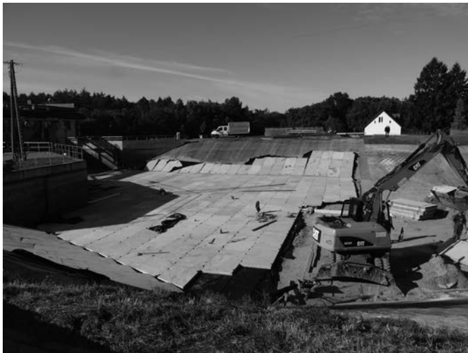
Rys. 5. Realizacja robót remontowych kanału przed wlotem do elektrowni 27.08.2014 roku (fot. W. Sterpejkowicz-Wersocki)
