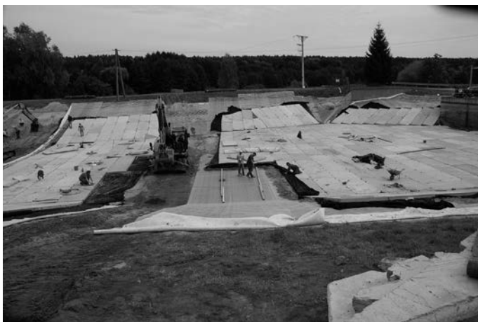
Rys. 7. Realizacja robót remontowych kanału 01.09.2014 roku (fot. W. Szudek)
