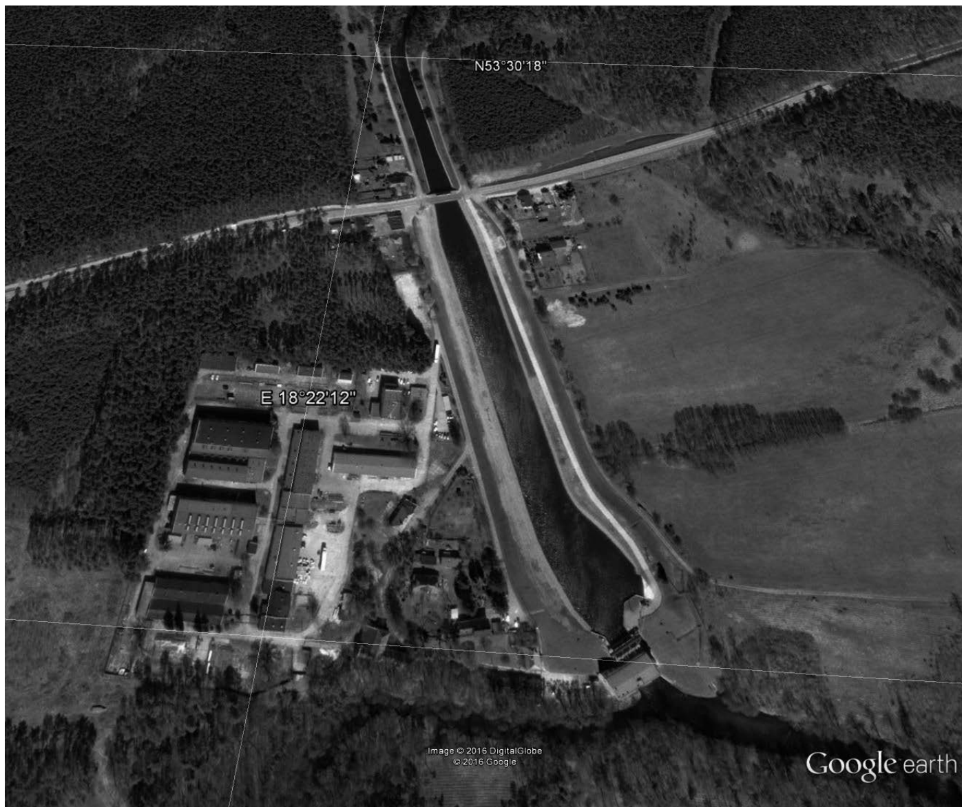
Rys. 2. Zdjęcie satelitarne kanału derywacyjnego EW Gródek – widoczna droga przecinająca kanał w miejscu jazu mostowego oraz elektrownia wodna u dołu zdjęcia (źródło: Google earth)
