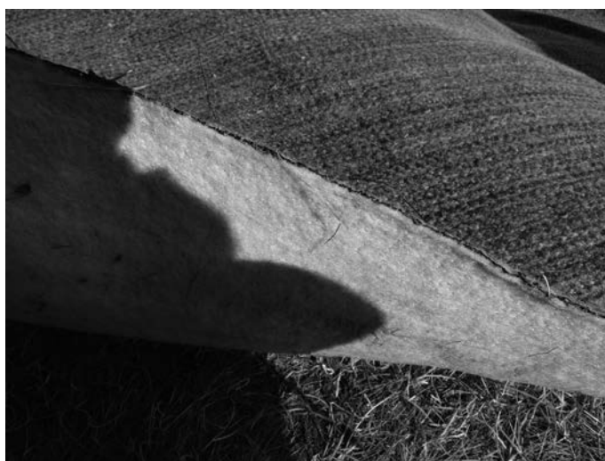
Rys. 4. Zastosowana mata bentonitowa w renowacji kanału (fot. W. Sterpejkowicz-Wersocki)
