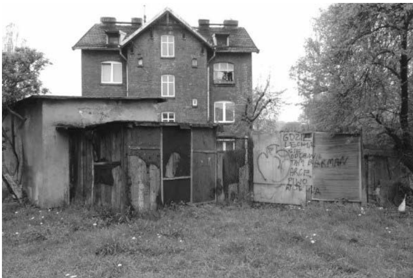
Ryc. 4. Podwórko przy ulicy Związkowej 4 i 6 – przed rozpoczęciem prac – wiosna 2013 234
