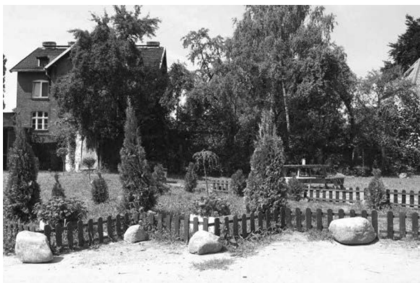
Ryc. 5. Podwórko przy ulicy Związkowej 4 i 6 – po zakończeniu prac – lato 2013 235
