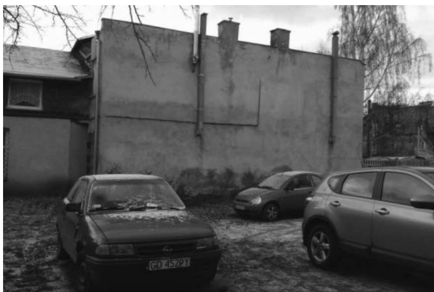
Ryc. 1. Podwórko przy ulicy Związkowej 1, 2 i 3 – przed rozpoczęciem prac – zima 2013 r. 230
