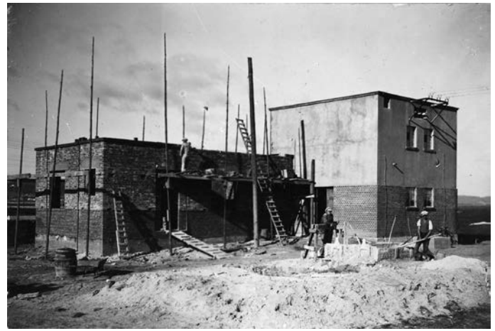
Rys. 5. Budowa parterowego budynku mieszkalnego obok hali pomp na ujęciu „Oksywie” (ze zbiorów MMG-HM-II-521-11)
