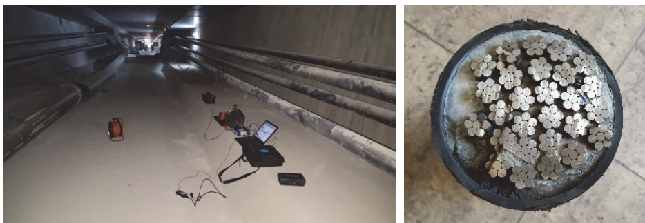
Rys. 1. Sprężenie zewnętrzne w żelbetowym moście sprężonym (fot. P. Kalitowski)
