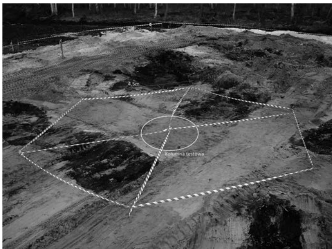
Rys. 4. Kolumna badana w otoczeniu sześciu kolumn wzmocniających
