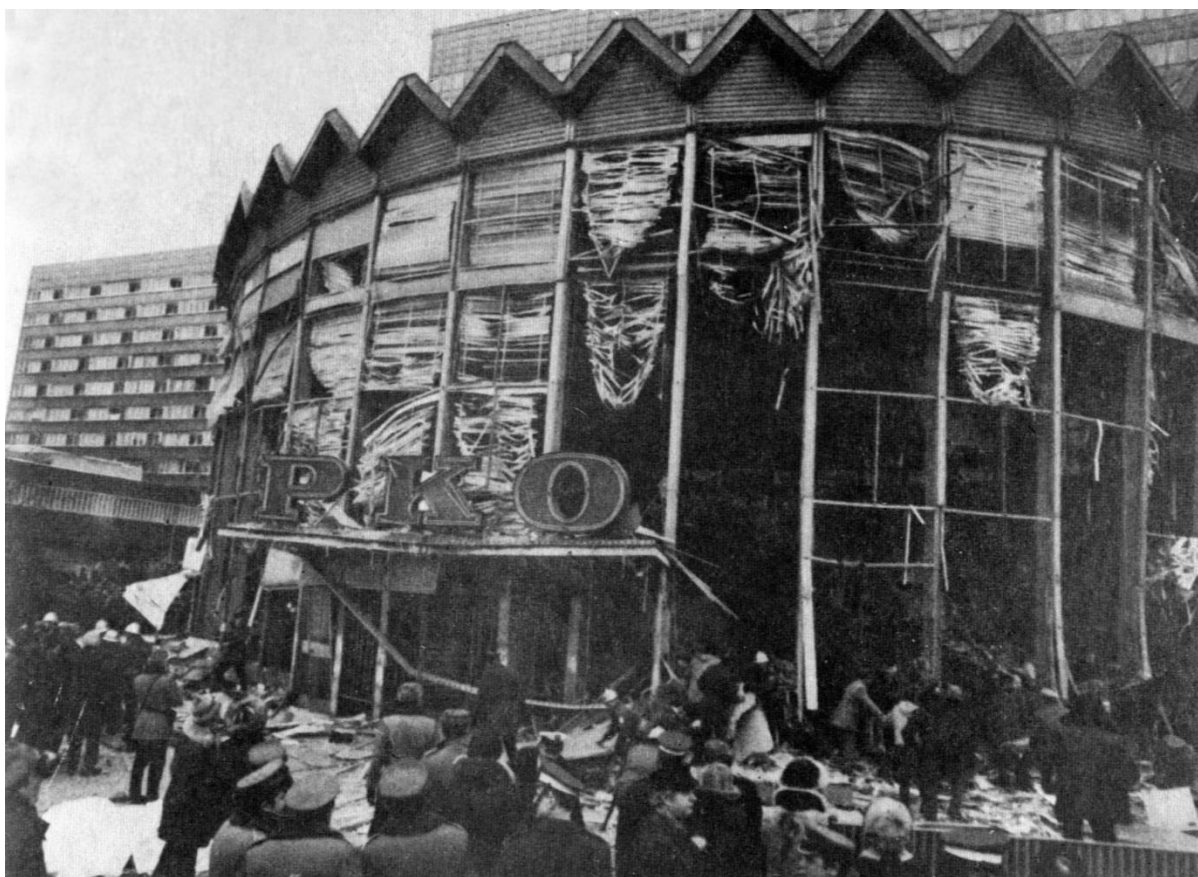
Rys. 5. Rok 1979 - zniszczenie obiektu na skutek wybuchu
