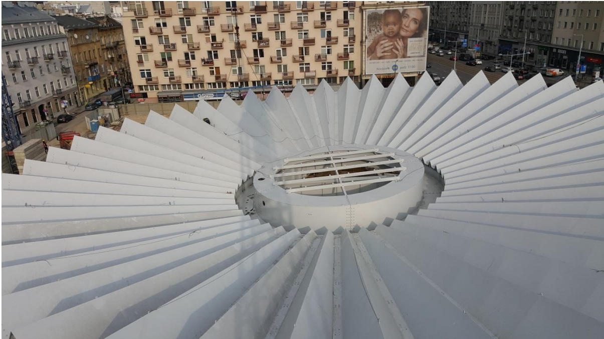
Rys. 19. Nowy, stalowy dach obiektu z naświetlem zlokalizowanym centralnie w obiekcie
