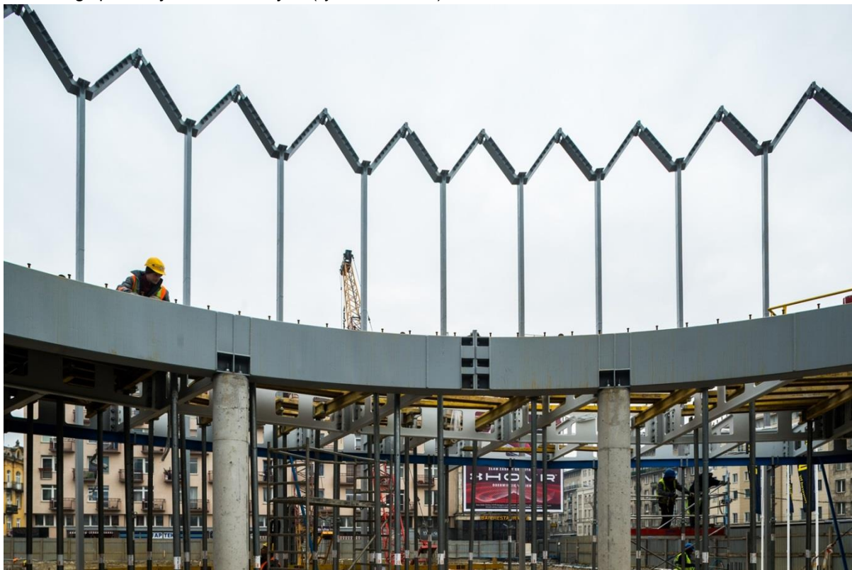
Rys. 17. Pierścień nośny ruszta antresoli i nośne słupy fasadowe po obrysie nowej Rotundy
