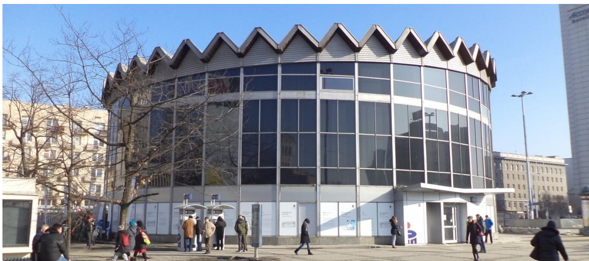
Rys. 7. Rotunda po odbudowie z charakterystycznymi wówczas ciemnymi szymbami i reklamami w pasie dolnym
