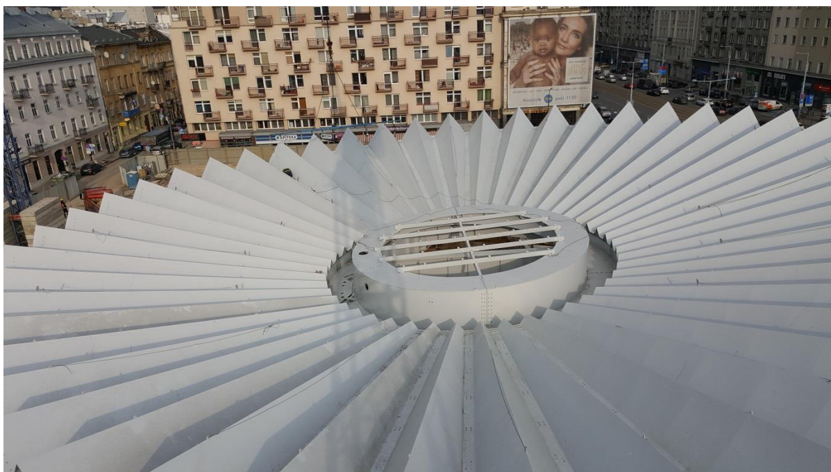
Rys. 19. Nowy, stalowy dach obiektu z naświetlem zlokalizowanym centralnie w obiekcie
