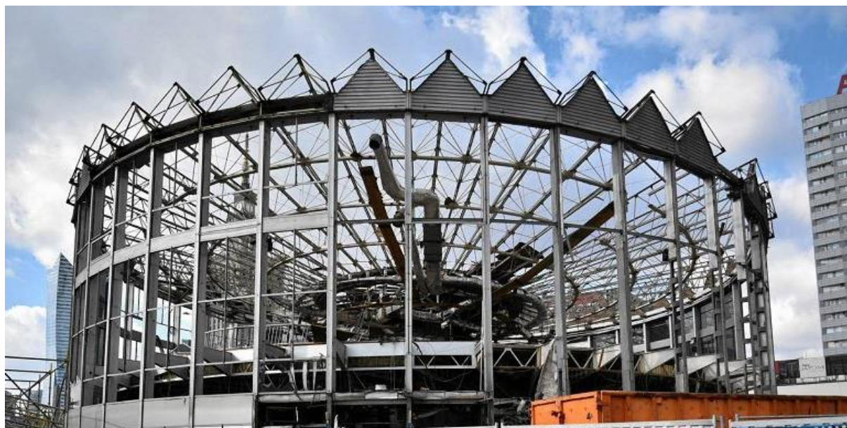
Rys. 14. Rozbiórka obiektu Rotundy - wiosna 2017 widoczna konstrukcja nośna ścian oraz trójkątne kratownicowe dźwigary dachowe
