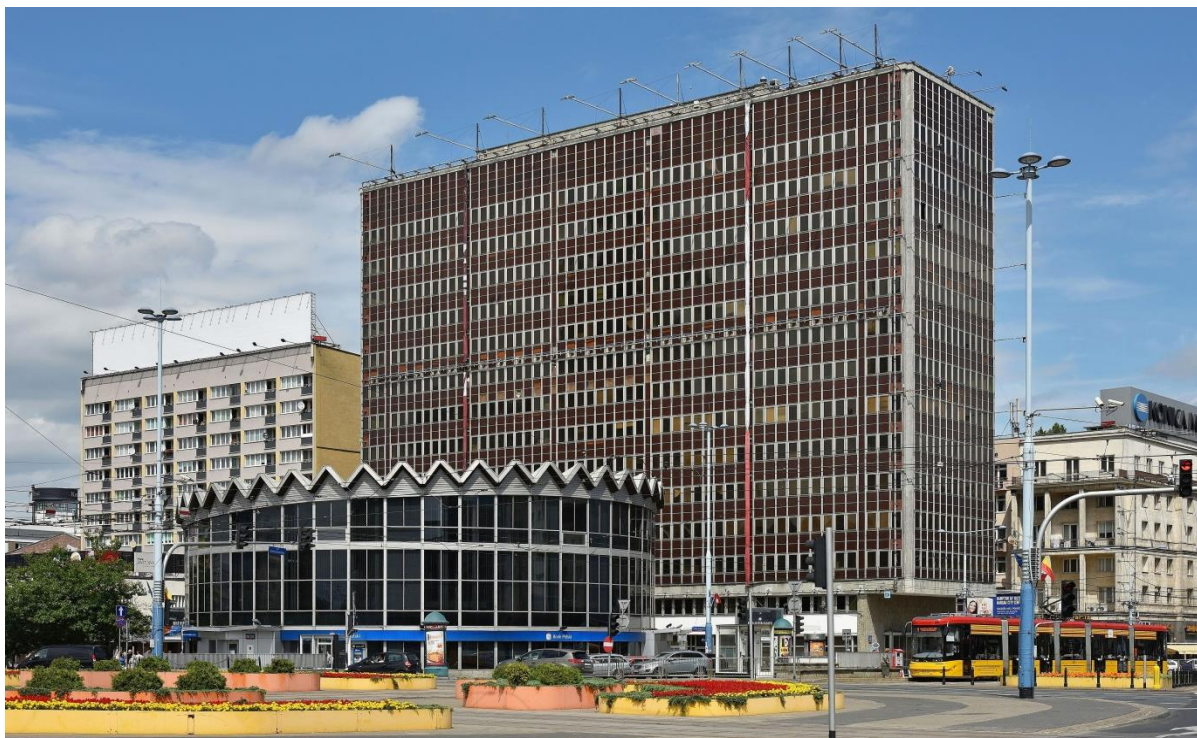
Rys. 1. Warszawska Rotunda PKO BP i budynek dawnego Uniwersalu w pełnej krasie na chwilę przed początkiem rozbiórki obu obiektów – rok 2016
