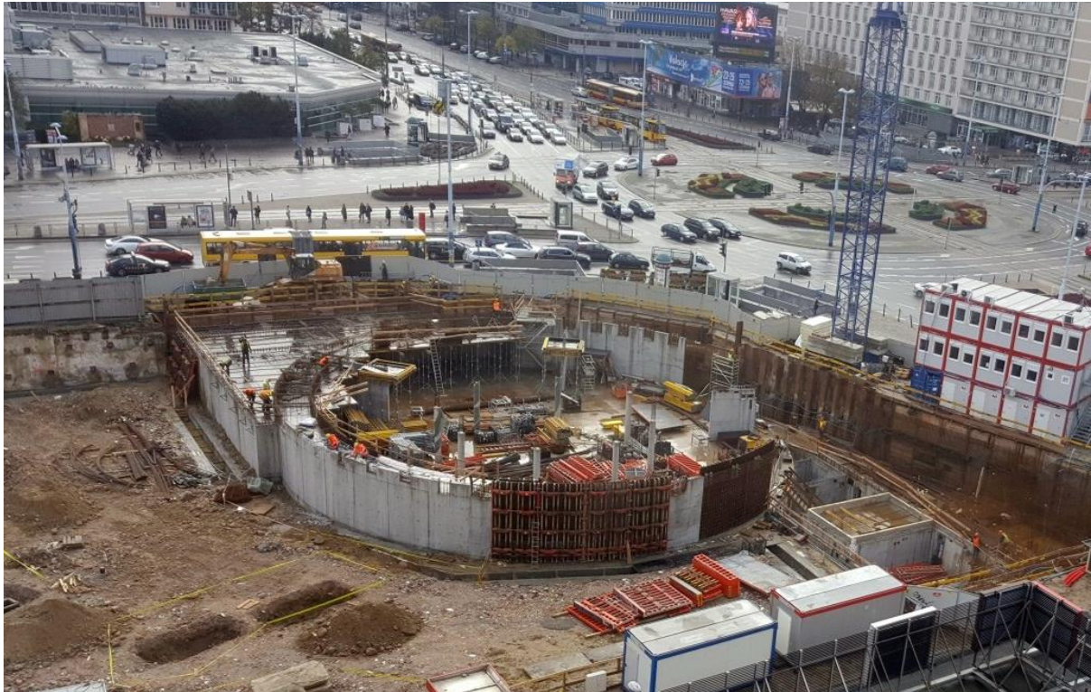
Rys. 15. Podziemna, żelbetowa część nowej Rotundy nabiera kształtów
