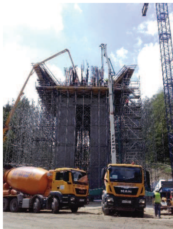
Rys. 5.15. (a) Betonownie płyty dolnej segmentu startowego, (b) Pobranie próbek do badań walidacyjnych, (c) Przechowywanie próbek i pomiar temperatury betonu
