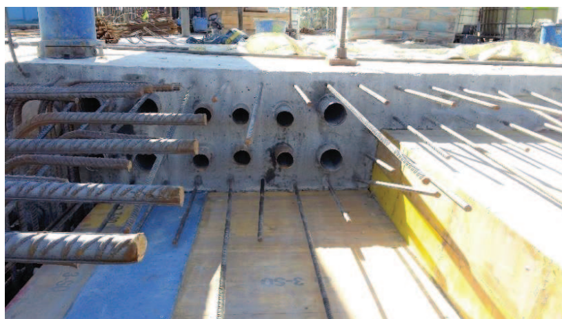
Rys. 5.33. (a) Widok płyty górnej, (b) Prefabrykowana listwa z czujnikami temp. zamocowana na pręcie
