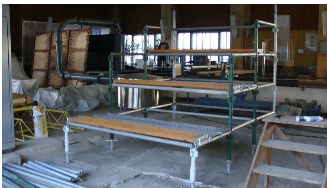
Fot. 5.1 Pusta tymczasowa trybuna stalowa (widok z przodu).
