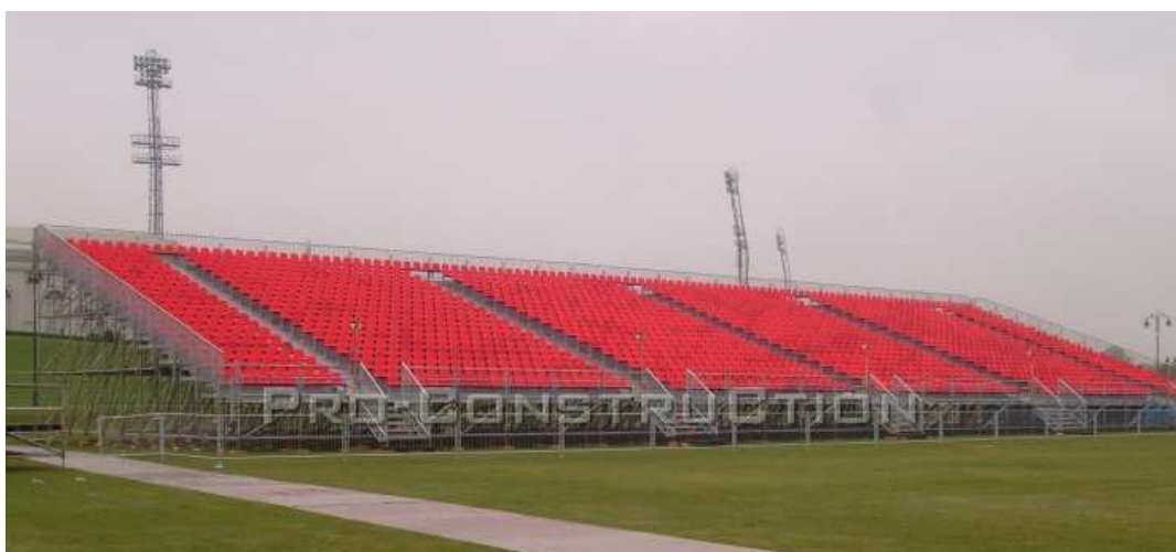
Fot. 2.5 Trybuna metalowa wznoszona za pomocą systemu rusztowań ( www.pro-construction.com ).
