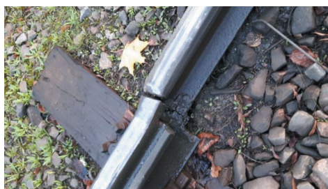
Fot. 1. Złamanie szyny w miejscu styku przejściowego pomiędzy szyną S49 oraz 60RiN Źródło: materiały własne
