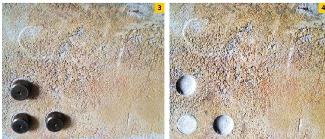
FOT. 3-4. Powierzchnia tynku lekkiego (ciepłochronnego) przed badaniem metodą pull-off według normy PN-EN 1542:2000 [1] (3) oraz po badaniu (4); fot.: autorzy
