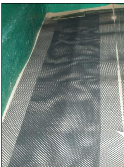
Rysunek 6.19 Siatka techniczna Złoty Stok na piance poliuretanowej, ułożona w dwóch warstwach
