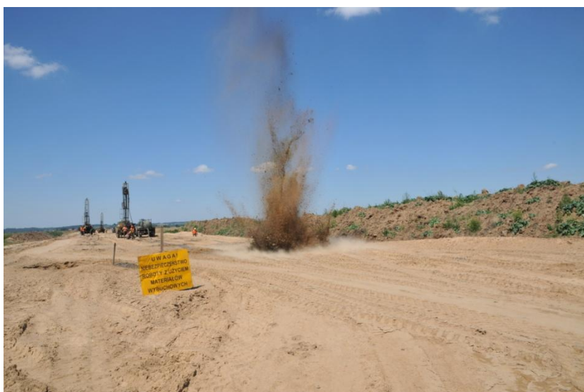
Rysunek 1.2 Mikrowybuchy (za uprzejmością Polbud-Pomorze Sp. z o. o.)
