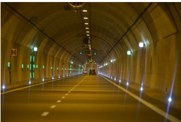
Fig. 3. Słowacki Route construction - the Task IV, source: http://www.gik.gda.pl/34/inwestycje/budowa_trasy_slowackie/go/zadanie_iv.html , access date: 28.06.2015.
