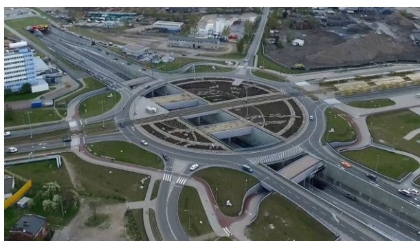
Fig. 2. Słowacki Route construction - the Task IV, source: http://www.gik.gda.pl/34/inwestycje/budowa_trasy_slowackie_go/zadanie_iv.html , access date: 28.06.2015.
